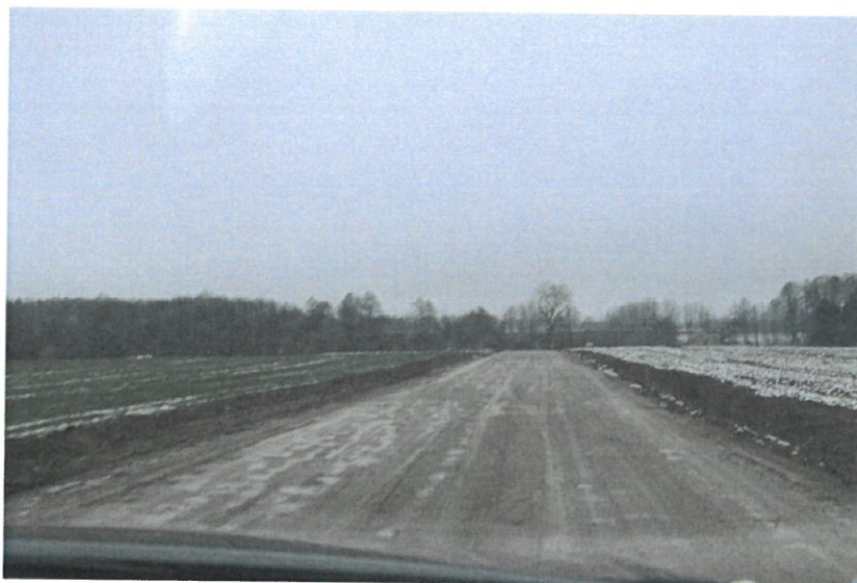
Droga 1243B przed przebudową
