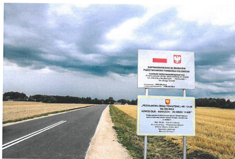
Droga 1243B po przebudowie
