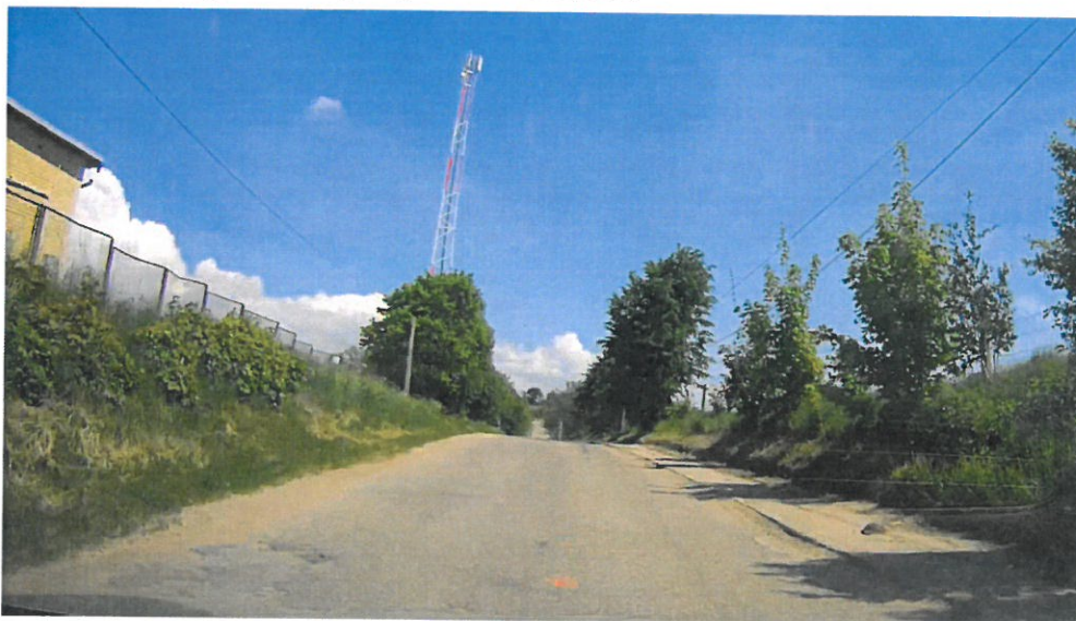
Droga 1249B – ulica Sidrzańska przed przebudową
