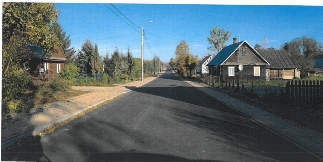
Droga nr 1262B po przebudowie
