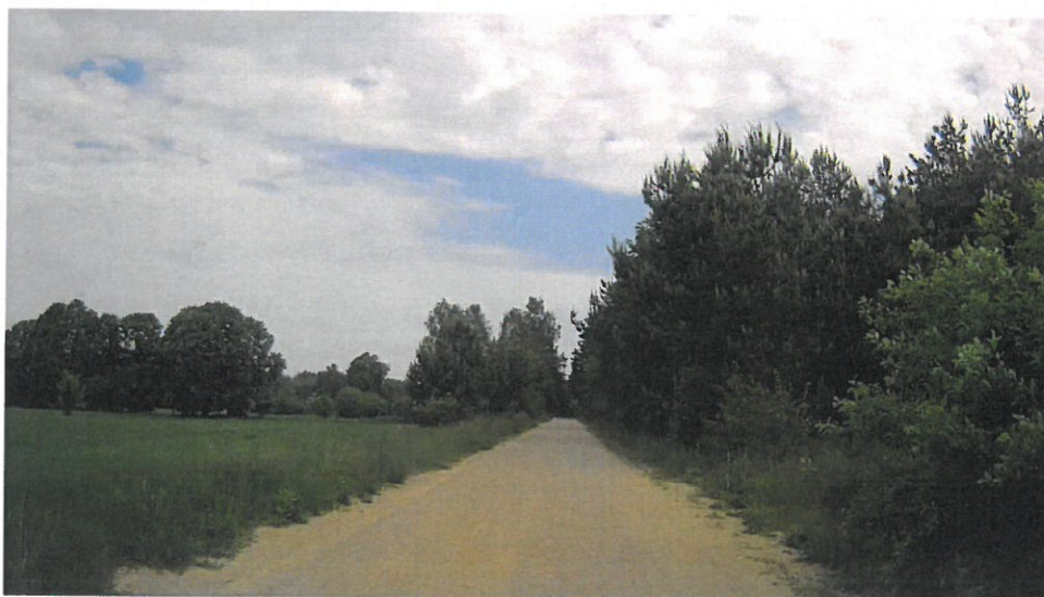
Droga 1262B przed przebudową
