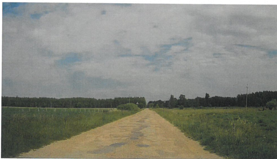
Droga 1262B przed przebudową
