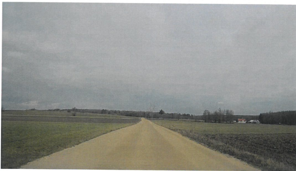
Droga nr 1266B przed przebudową
