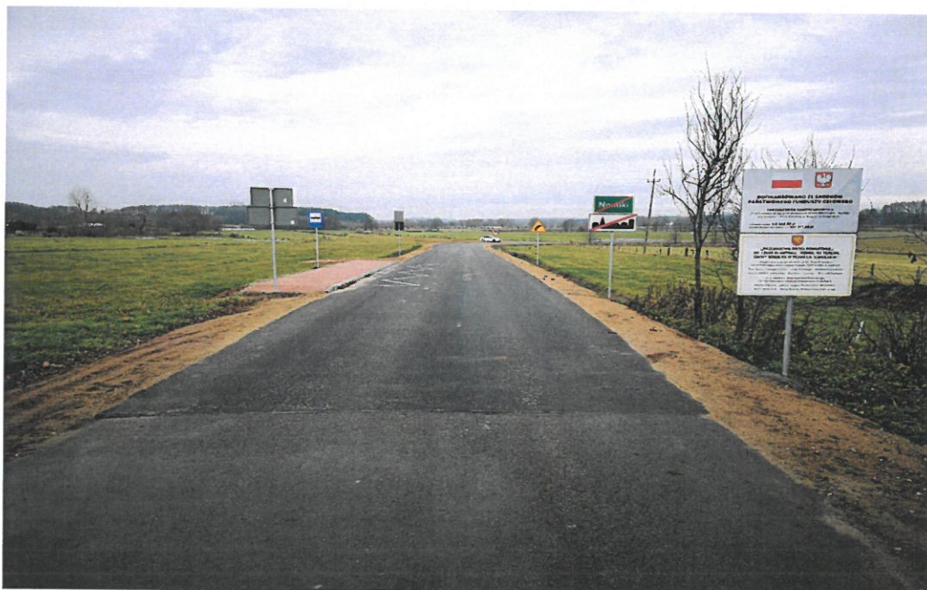
Droga nr 1266B po przebudowie
