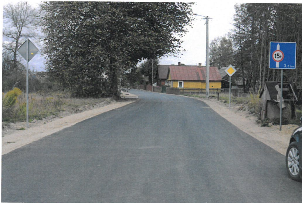
Droga 1278B po przebudowie (m. Górzany)
