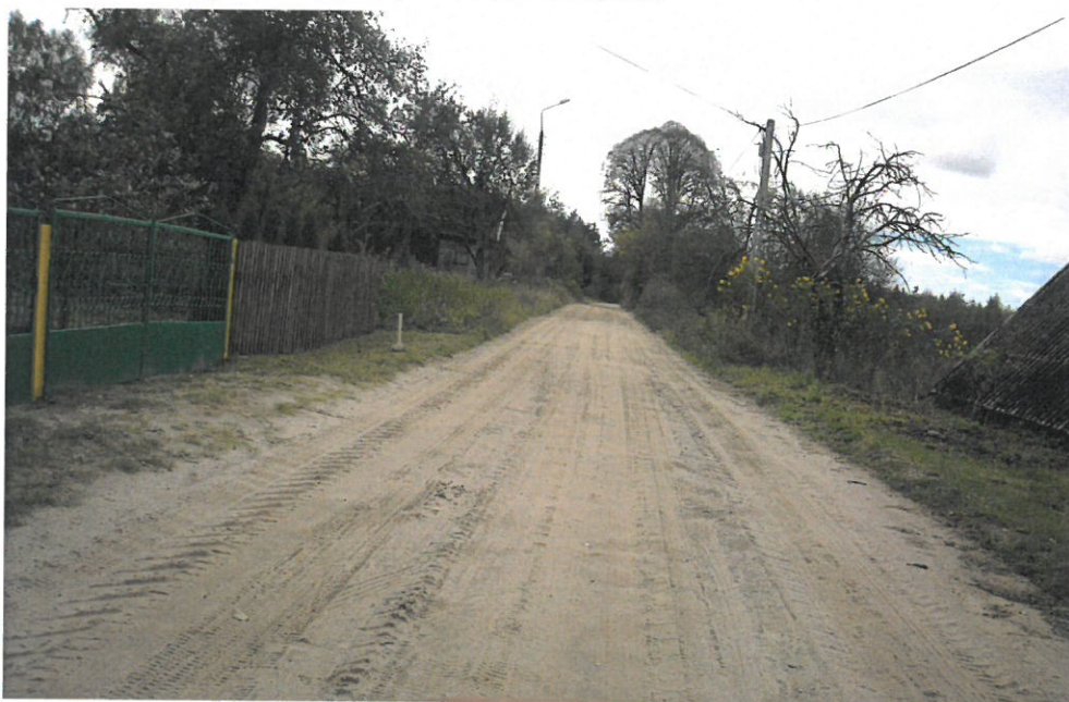
Droga 1278B przed przebudową (m. Górzany)
