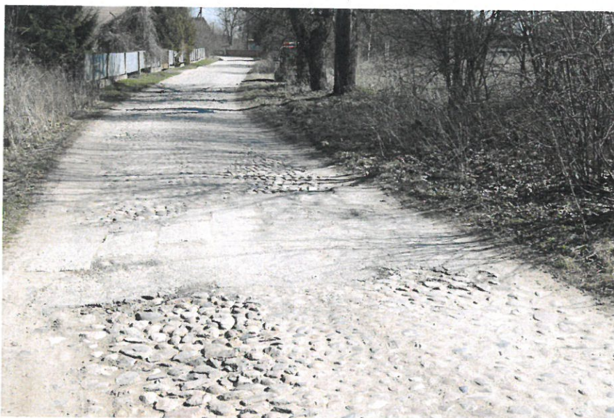
Droga 1289B przed przebudową
