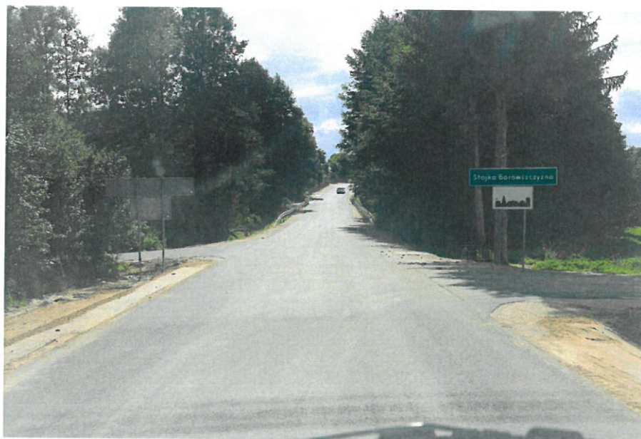
Droga 1289B po przebudowie
